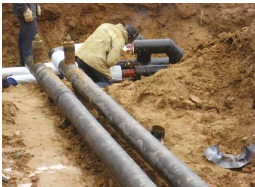
Монтаж тепловых сетей
